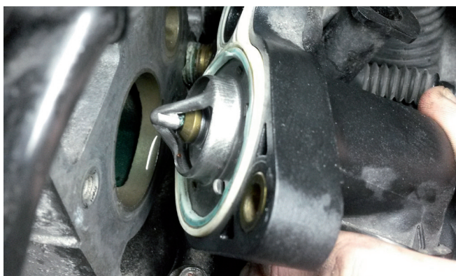
Εικόνα 1: Μόλις ανοίξει το κύκλωμα ψύξης, εξέρχεται νερό ψύξης, ενώ εισέρχεται αέρας στο σύστημα.
