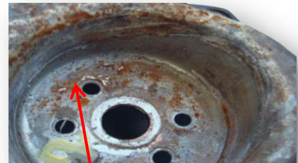
Durch Bewegung der Feder verursachte Korrosion
